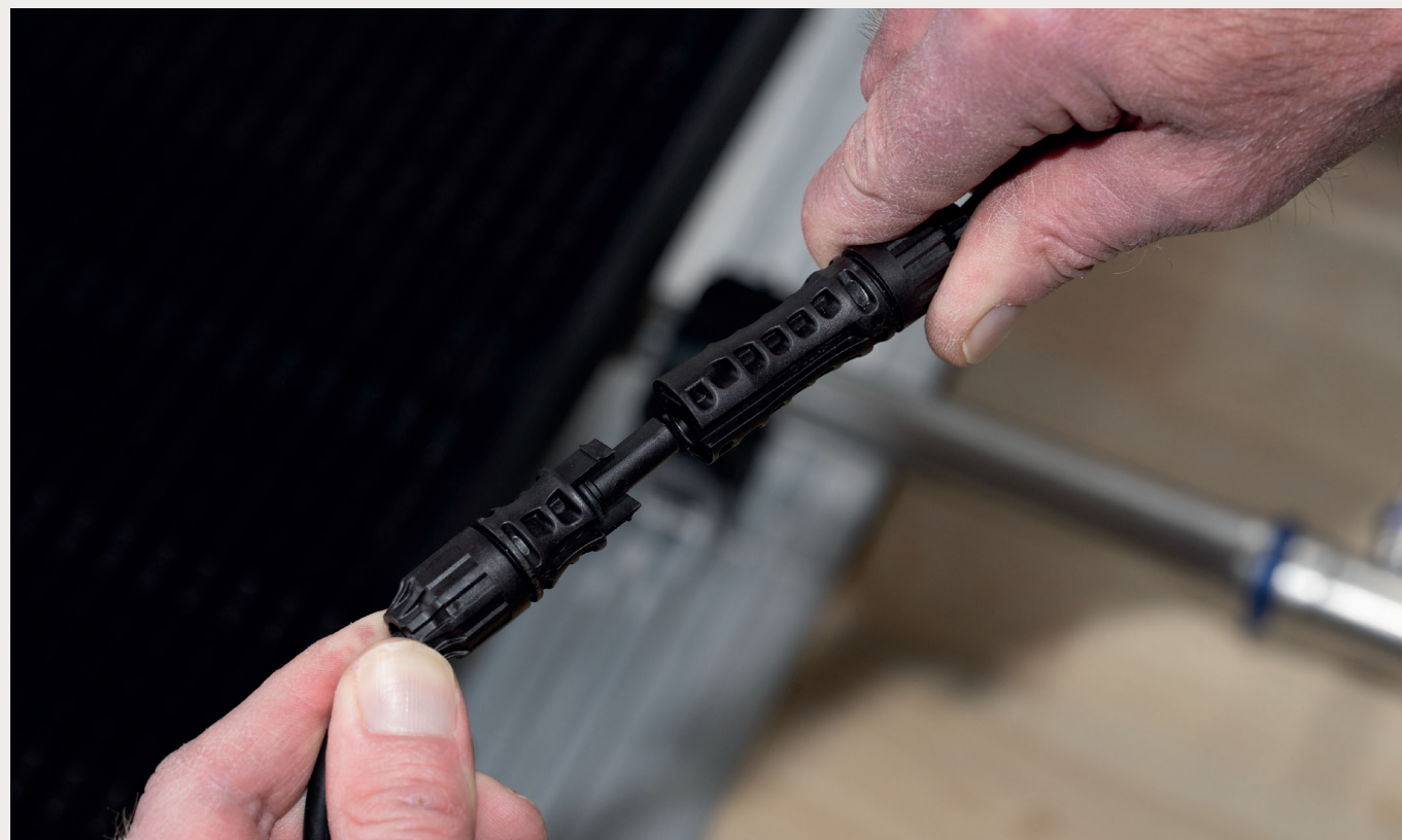
Abb. 05: Verbinden der elektrischen Leitung
