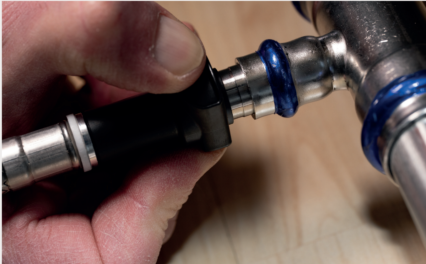
Abb. 11: Anbringen des Anschlussschlauches am Rohrleitungssystem
