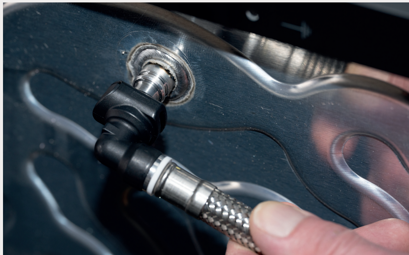
Abb. 08: Anbringen des Anschlusschlauches am PVT-Modul
