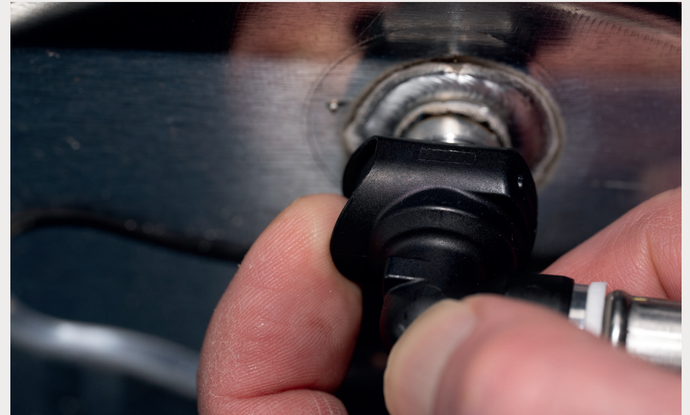
Abb. 09: Anbringen des Anschlusschlauches am PVT-Modul
